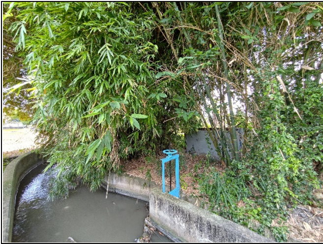
工區一：台中市霧峰區南勢西段1173地號 鑿井位置工址現況
