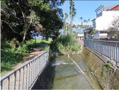
工區一及工區二施工起點環境
