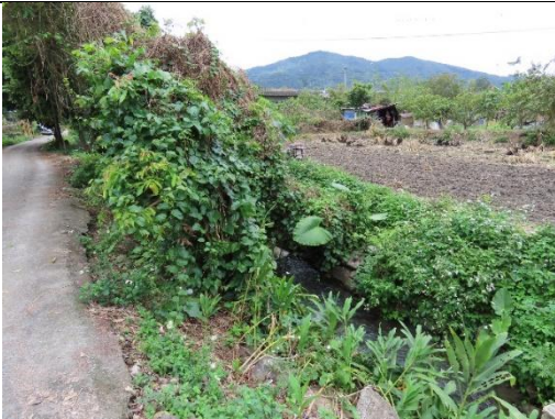
工區三施工起點環境
