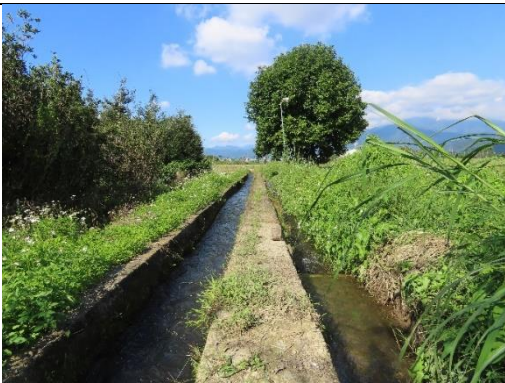
工區一及工區二中段環境
