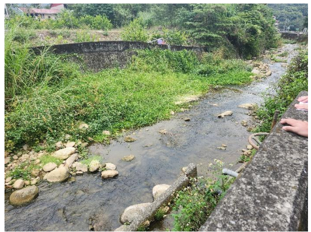
說明：114年12月19日，現勘工區三-史港坑排水幹線
