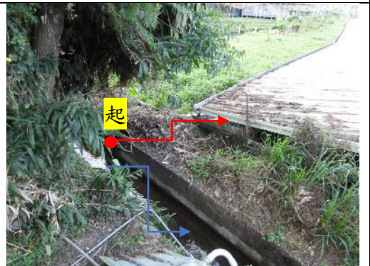
工區南側銜接既有渠道
