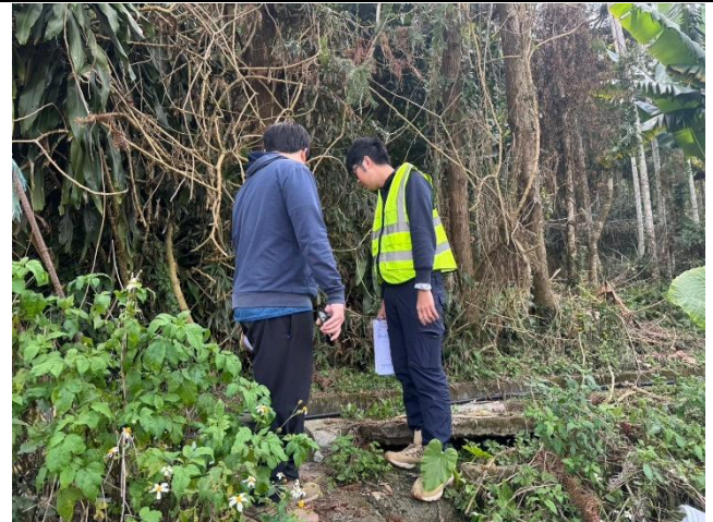
說明：本團隊與規劃生態團隊、廠商討論新城圳第二支線現場環境狀況，與後續工程施作方式。
