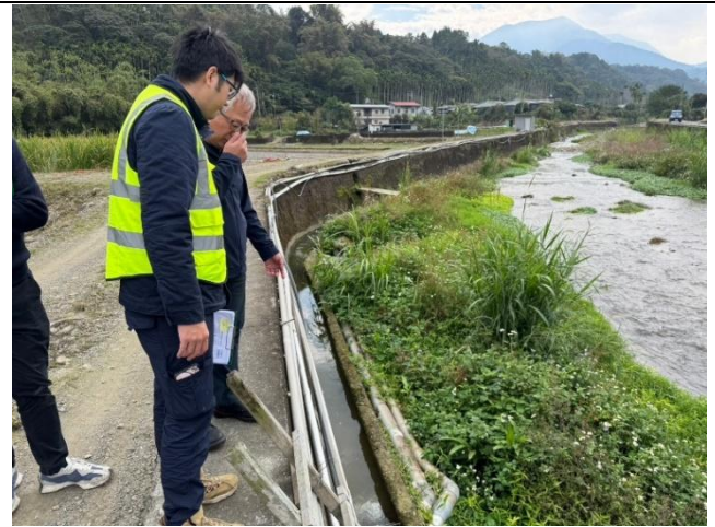
說明：魚池工作站李副工程師說明木屐蘭溪右支線後續施工範圍與方法。
