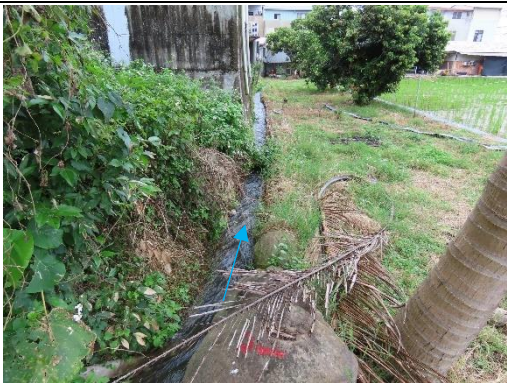
工區四工程起點環境
