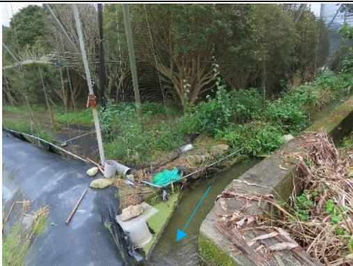
工區二工程終點環境
