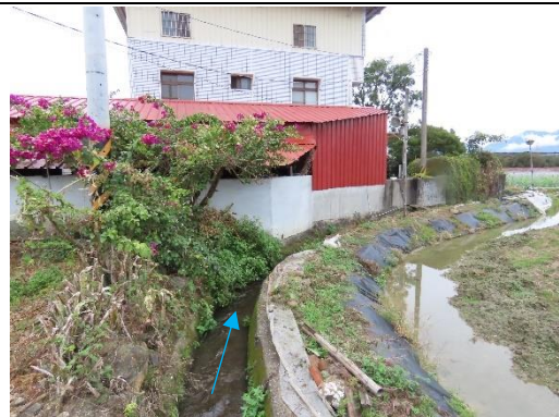
工區二工程起點環境
