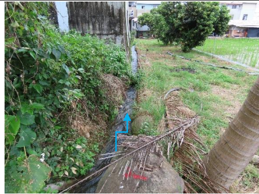
工區四工程起點環境
