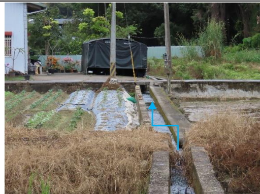
工區三工程終點環境
