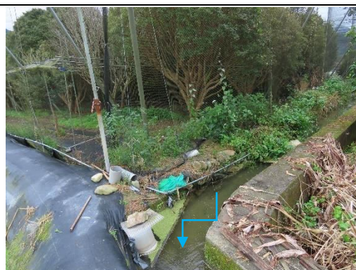
工區二工程終點環境
