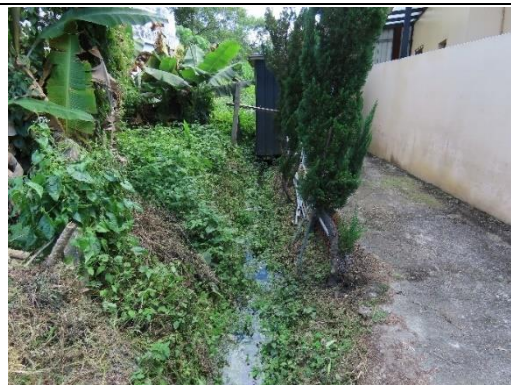
工區五茄苳腳圳工程終點環境
