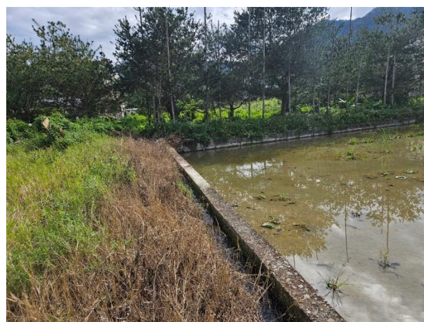
說明：114年1月8日，現勘工區三-珠子山圳右支線2分線1小給
