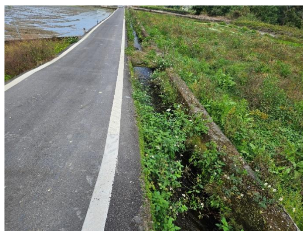
說明：114年1月8日，現勘工區一-珠子山圳右支線
