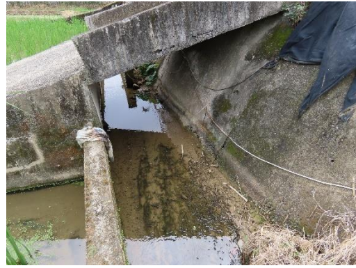
工區二工程起點環境
