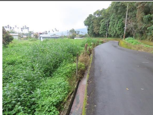
工區四工程起點環境
