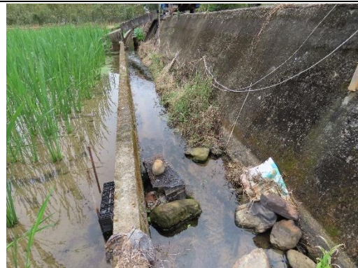
工區二工程起點環境
