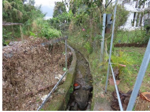
工區三工程起點環境
