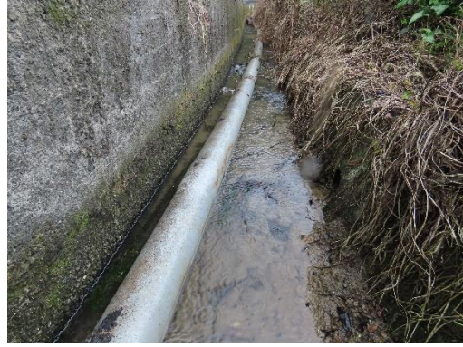
工區四工程終點環境
