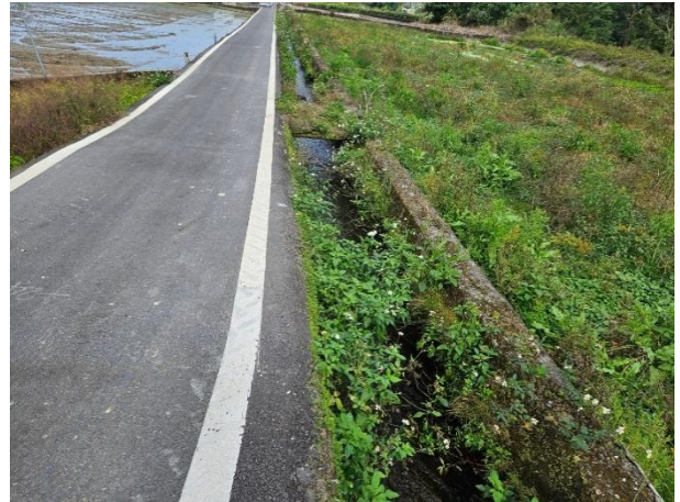
說明：114年1月8日，現勘工區一-珠子山圳右支線
