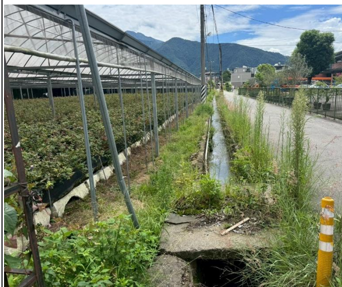
(南投 114A03-03)北烘圳橫圳支線 工區環境照-1
