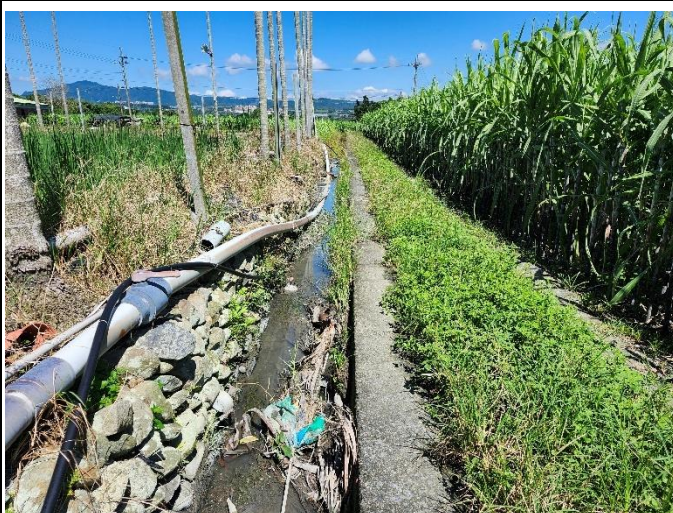
(南投 114A03-01) 守城份圳內埔八支線五號分線 工區環境照-2
