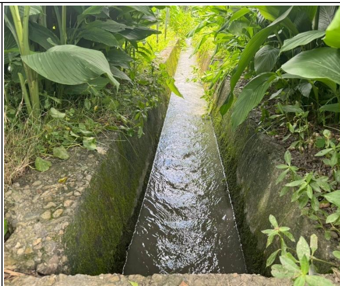
(南投 114A03-02)守城份圳牛眠 2 支線 工區環境照-2
