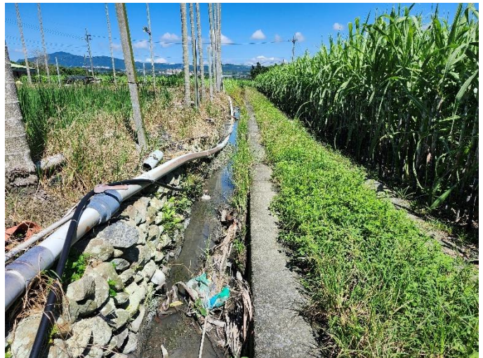
(南投 114A03-01) 守城份圳內埔八支線五號分線 工區環境照-2
