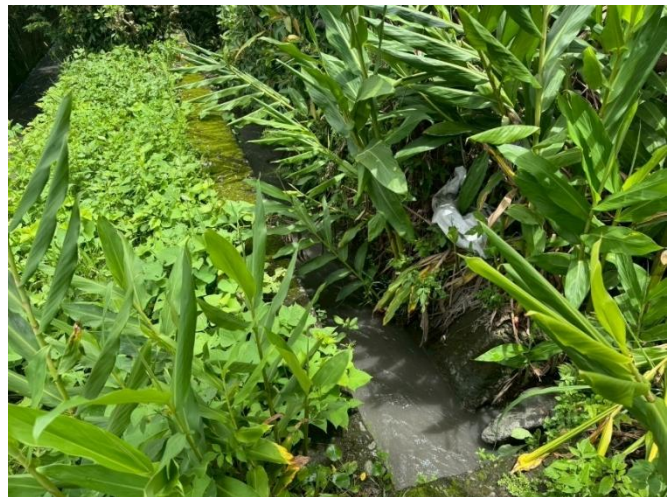
(南投 114A03-02)守城份圳牛眠2支線 工區環境照-1
