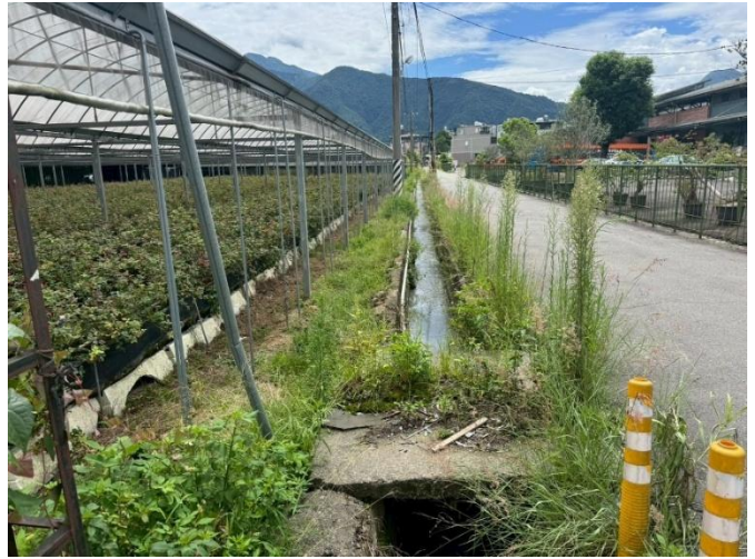
(南投 114A03-03)北烘圳橫圳支線 工區環境照-1
