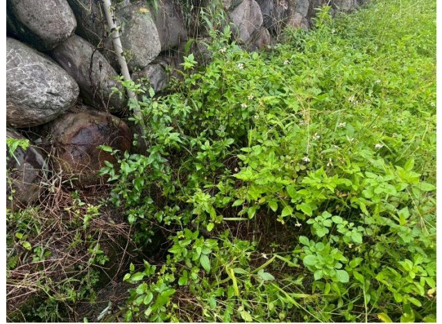
時間：114年6月18日 說明：國姓圳幹線三支線(工區四)周邊環境照
