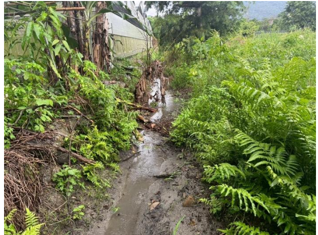
(南投 114A06-04)國姓圳幹線三支線 工區環境照
