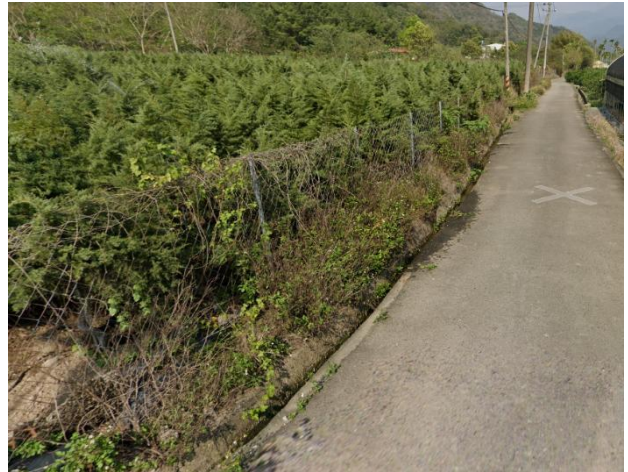
(南投 114A06-05) 北圳幹線埔尾六支線 工區環境照
