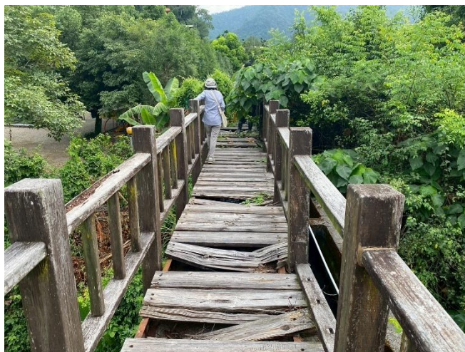
(南投 114CR102) 北圳橋木棧道環境照
