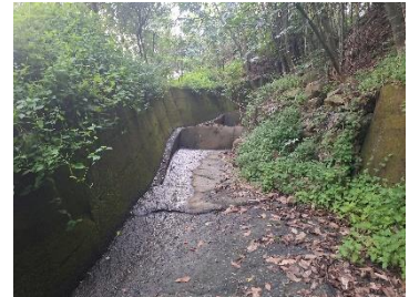
工區 1 工程起點可見苦草屬植物，圳路有破損情形
