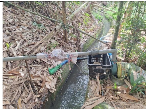
圳路兩旁為次生林可供野生動物棲息利用，建議可設置小型跨橋，使動物可以橫向穿越，避免落入渠道。
