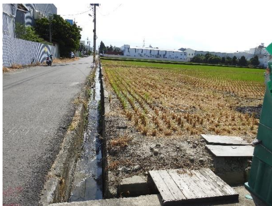
阿罩霧第二幹線喀哩 2 號埤支線 1 分線 4 小給環境現況
