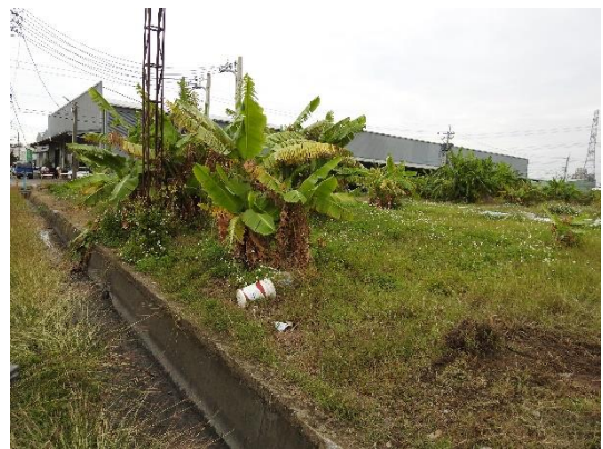
溪埧排水螺潭 1 中排 1 分線環境現況
