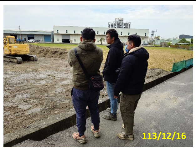
說明:生態團隊夥同監造單位、營造廠商至現場勘查
