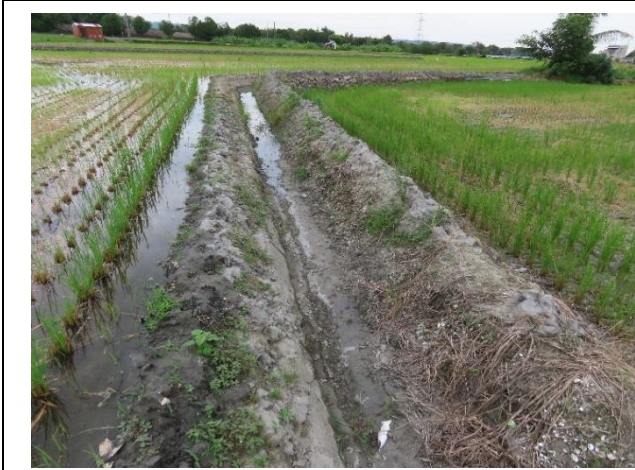
時間：113/11/19 說明：四股圳支線 1 小給強化工程
