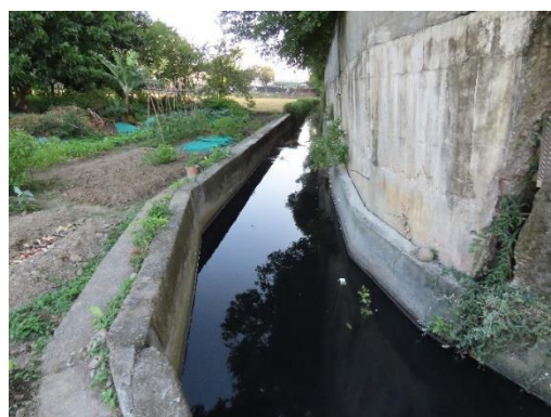
草湖溪 1 中排工區周邊陸域棲地環境
