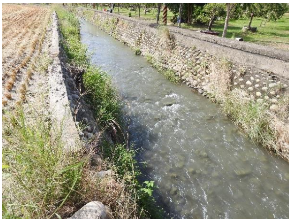
時間：113年11月27日 說明：同安北圳改善工程周邊環境
