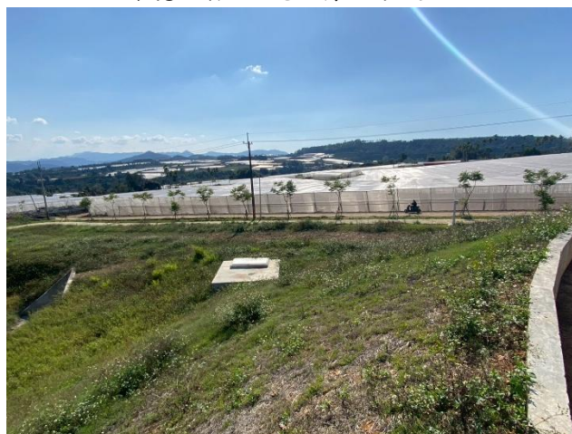
滯洪池周邊環境現況
